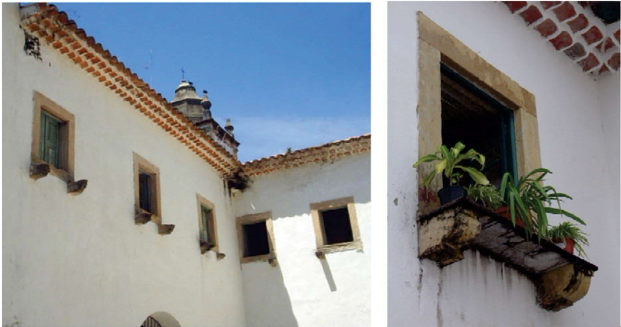
Figura 2: Vista das fachadas laterais do Convento de Santa Maria Madalena e detalhe de janela da cela com apoio para vasos no Convento de Olinda. (Acervo do Grupo de Pesquisa Estudos da Paisagem).
