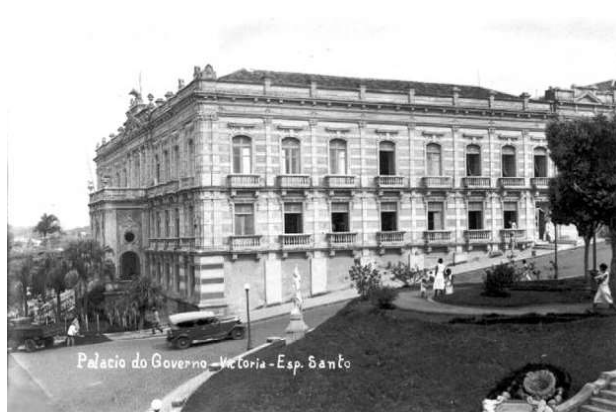
Figura 4: Colégio dos jesuítas, depois da reforma. Fonte: Arquivo Público ES e SEDEC/PMV. Acesso 1.ago.2009.
