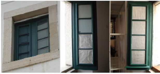
Figura 3: Caixilhos originais da sala, teste com diferentes tipos de películas de materiais opacos e caixilho pronto com aplicação de Tyvek, para reduzir carga térmica
