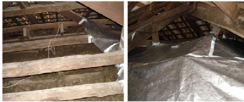
Figura 2: Desenho esquemático do forro do Salão Nobre e detalhe da colocação da lâ de rocha sobre o forro e da manta contínua de Tyvek. Desenho e fotos da autora.
