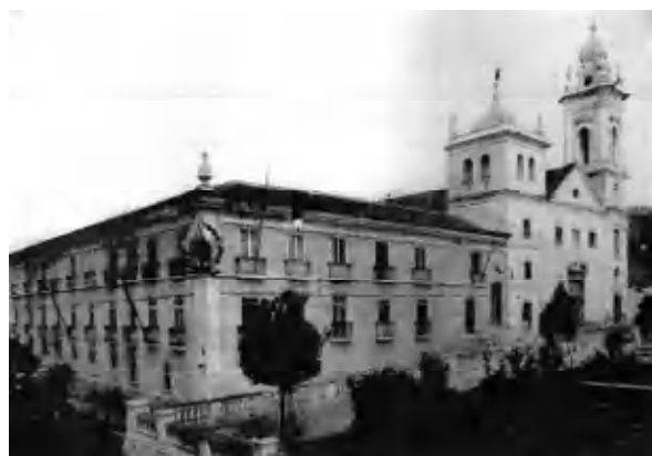
Figura 3: Colégio dos jesuítas e igreja de São Tiago, antes da reforma. Fonte: Arquivo Público ES e SEDEC/PMV. Acesso 1.ago.2009.
