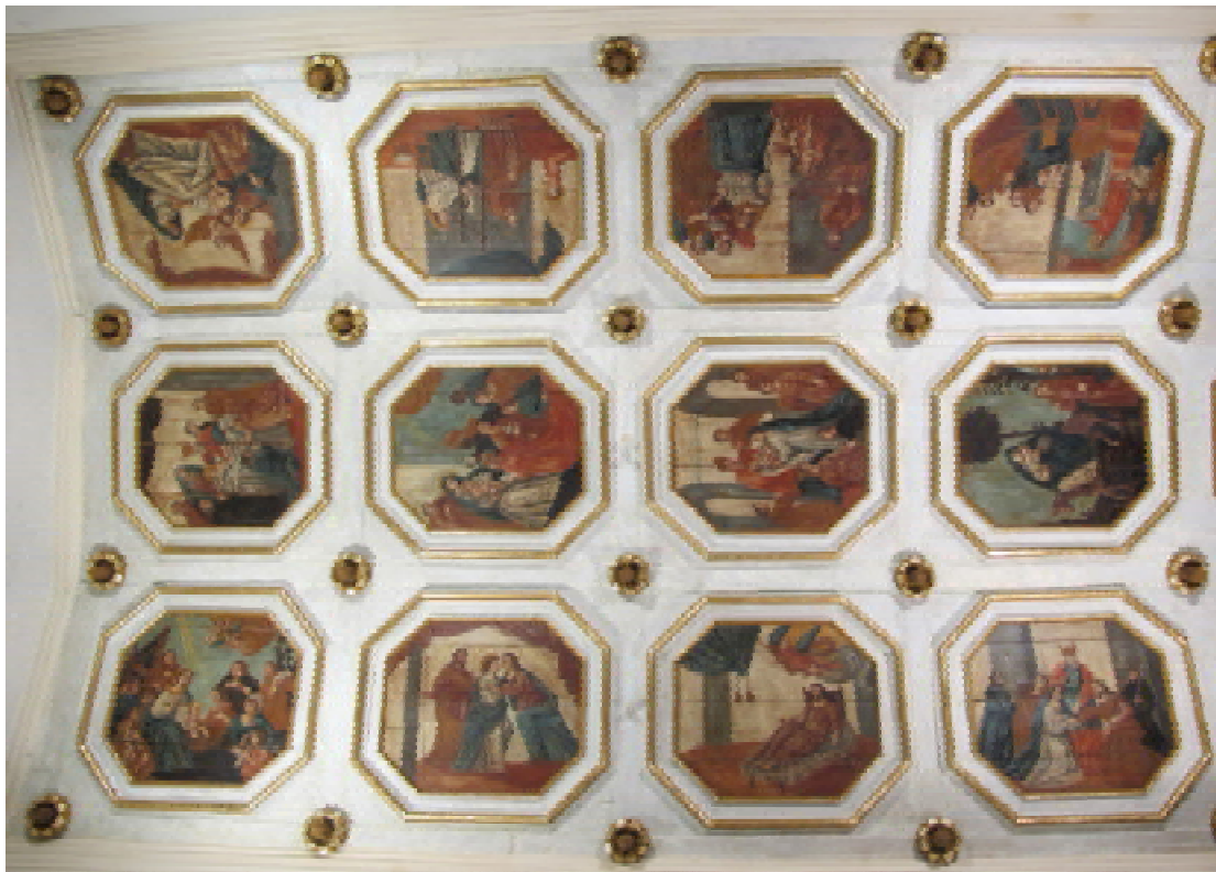
Figura 1: Visão geral do conjunto. Anônimo, anterior 1790, Igreja de São José de Ribamar, Aquiraz.
