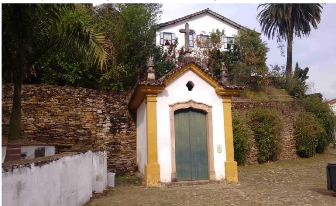
Figura 1 - Passo de Rua próximo à Ponte Seca, vista externa para fachada, Ouro Preto/MG.
