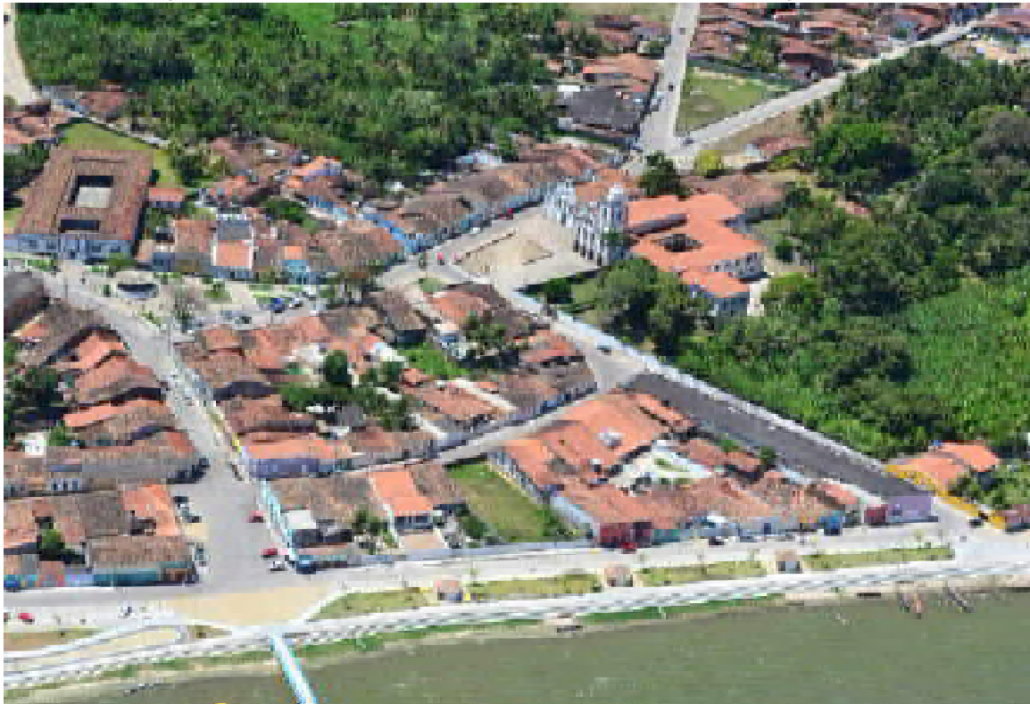
Figura 5 – Convento de Santa Maria Madalena, em Marechal Deodoro, Alagoas.
