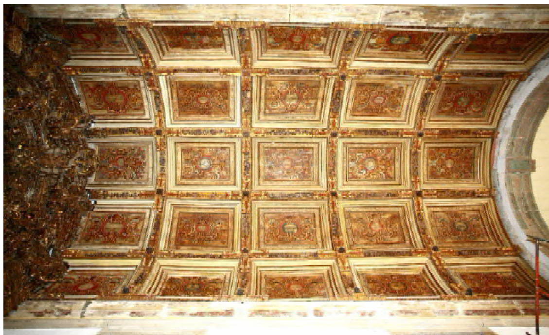
Figura 8 - Forro da capela-mor do Convento de Santa Maria Madalena, em Marechal Deodoro/AL
