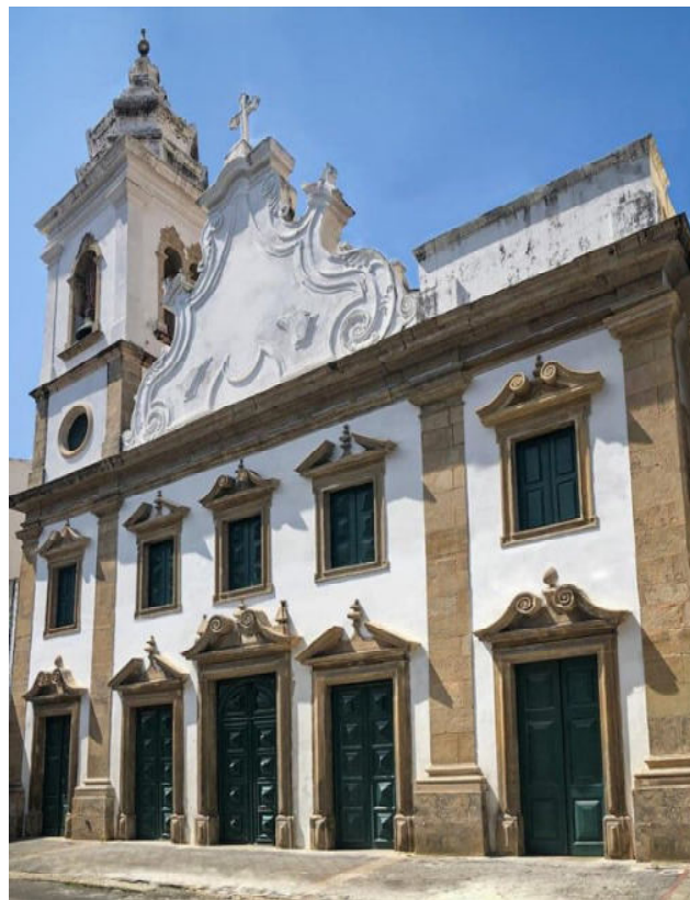
Figura 1 – Fachada da Igreja de Nossa Senhora da Conceição dos Militares.
