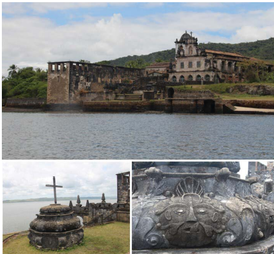
Figura 3: Elementos do adro do convento de Paraguaçu
