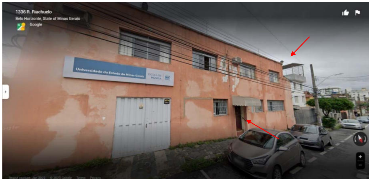
Figura 3 – Fachada do primeiro edifício (vermelho) da ESMU-UEMG principal; e à direita da imagem o segundo edifício (branco). com setas indicando a entrada.
