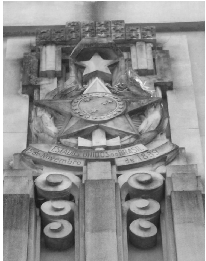
Figura 23 Fachada da Prefeitura de Belo Horizonte. Detalhe. 2018. Arquivo do autor.
