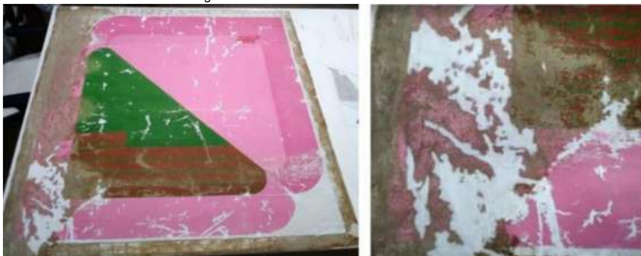
Figura 35 - Nivelamento com tinta Látex PVA
