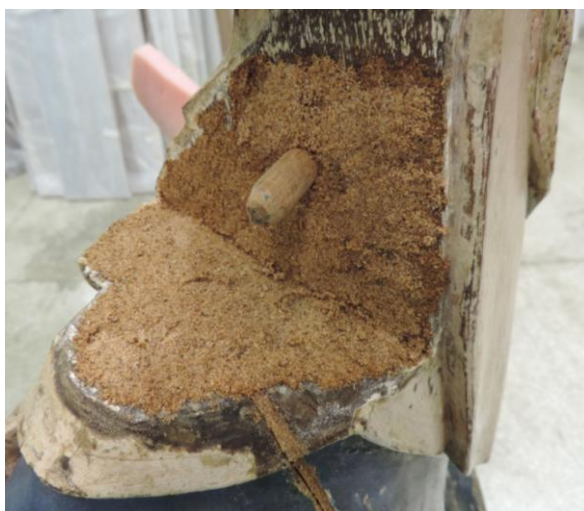
FIGURA 63 - Aplicação de massa de consolidação com serragem e PVA diluído(1:1) em água deionizada, na proporção de (1:1) (Cascorez®, rótulo azul). Foto: R.H.Gonçalves
