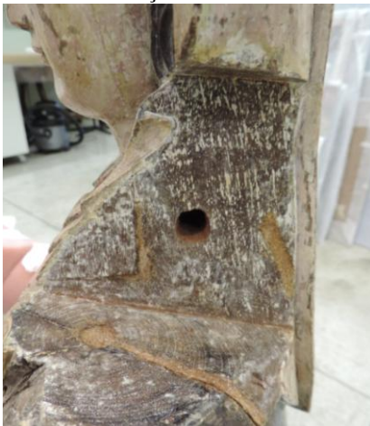
FIGURA 59 – Parede do bloco após da perfuração do orifício. Foto: R.H.Gonçalves
