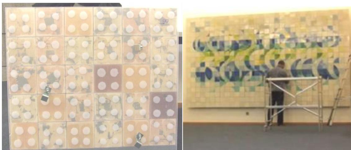
Figura 27: Painel Ritmo de Ondas, de Eduardo Nery. a) Assentamento dos azulejos em placas de acrílico com a utilização de silicone como adesivo. b) Montagem do painel.
