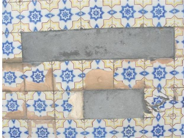
Figura 22: Fachada de azulejos onde se pode perceber o destacamento do vidroado em torno da intervenção com cimento *Portland*.
