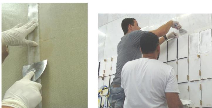
Figura 26: Plataforma modular de fibroresina *Honeycomb*. a) Preparação da plataforma com fixação de fita de fibra de vidro. b) Assentamento dos azulejos com adesivo *Brancol*.
