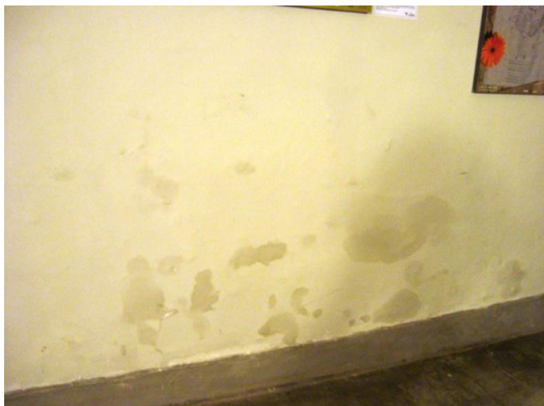
**Figura 20 - Infiltração na parede da galeria.**
