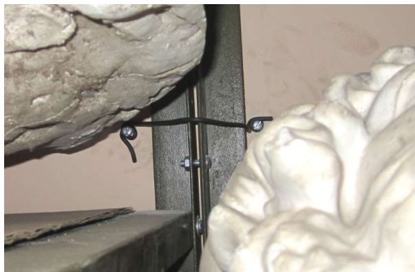
Fig. 28. Sistema de fixação das estantes.
