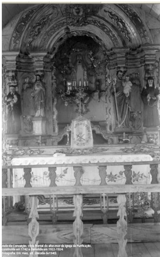
Figura 5 - Retábulo-mor, Igreja da Purificação (demolida), São João del Rei-MG. Foto: Eric Hess, 1940.
