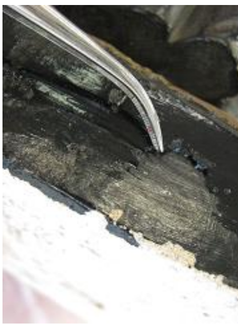
Figura 97 Remoção da repintura Foto: Luzia Marta
