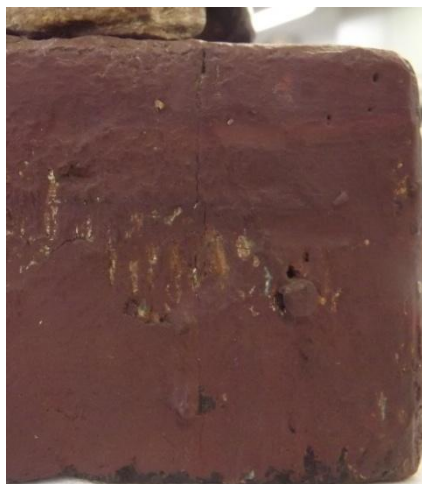
Figura 41 - Prego e fissura observada na lateral esquerda. Foto: Fernanda Moura.
