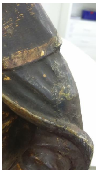
Figura 34 - Detalhe da emenda feita de epóxi na capa no lado esquerdo. Foto: Fernanda Moura.
