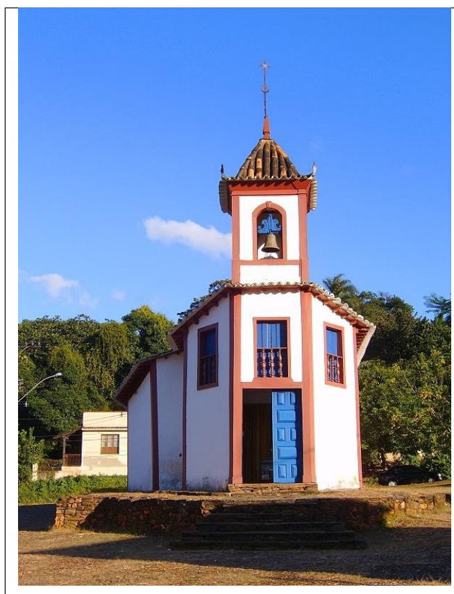
Figura 5: Foto do lado externo da Igreja de Nossa Senhora do Ó. Fotografia disponível em http://www.trekearth.com/gallery/South_America/Brazil/Southeast/Minas_Gerais/Sabara/photo602363.htm
