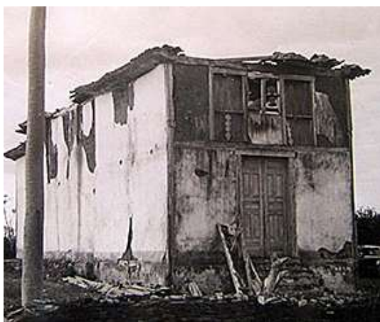
Figura 16: Imagem do desabamento do telhado da Capela.
