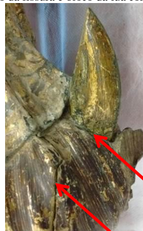
FIGURA 28 – Detalhe da parte direita da nuvem com o alargamento da fissura e bloco da lua com mobilidade.
