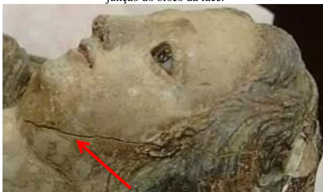
FIGURA 26 – Detalhe demonstrando o aumento da fissura na junção do bloco da face.
