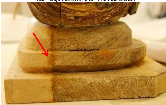
FIGURA 52 – Consolidação de pequenas fendas na junção dos blocos. Possível observar também a diferença entre as cores das madeiras da intervenção anterior e do bloco acrescido.
