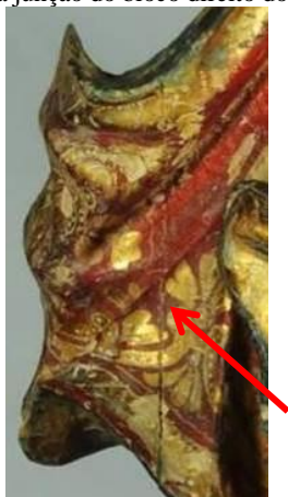
FIGURA 27 – Detalhe evidenciando o alargamento da fissura na junção do bloco direito do manto.
