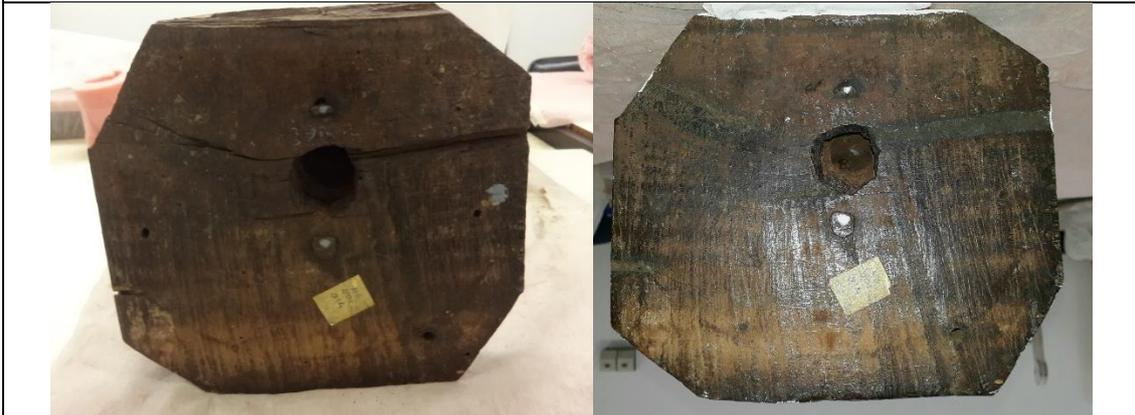
Figura 102 - Antes e depois de consolidação das rachaduras existentes na parte inferior da base adaptada.
