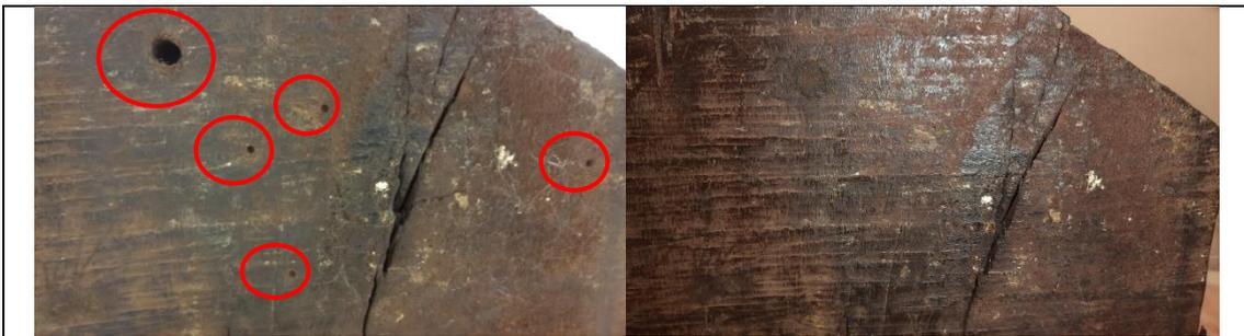
Figura 101 - Antes e depois de consolidação dos orifícios existentes na parte inferior da base adaptada.
