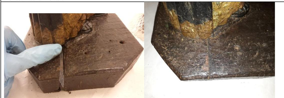
Figura 103 - Antes e depois de consolidação de rachadura existente na lateral direita superior da base adaptada.
