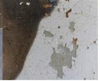
Fotografia 134- Após a remoção.
