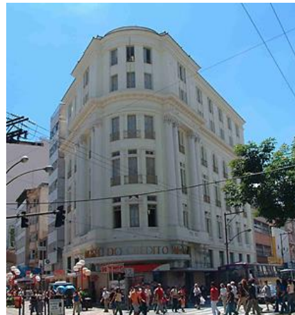
Figura 6- Vista atual do prédio.
