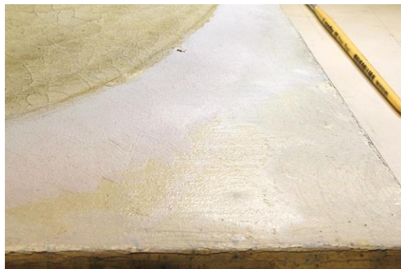
Fotografia 25- Concentração de verniz original.
