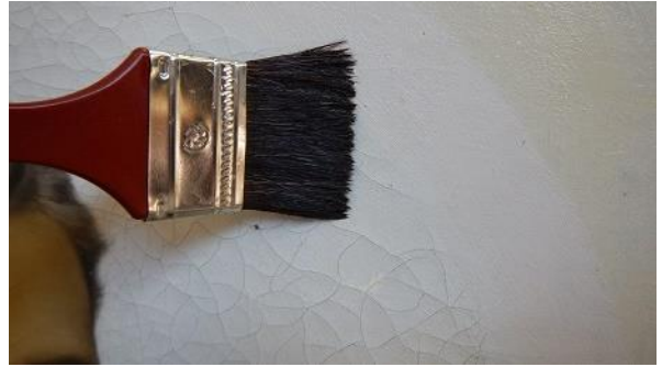
Fotografia 172- Aplicação do verniz de interface (horizontal).
