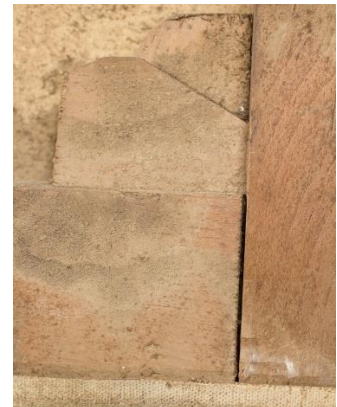
Fotografia 21- Detalhe das cunhas.
