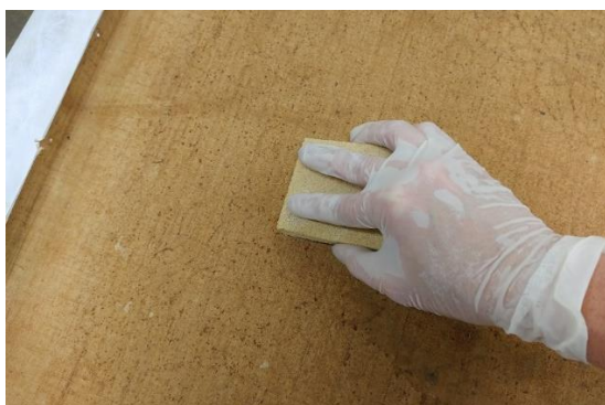
Fotografia 100- Limpeza com pet-rubber.
