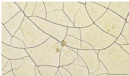
Fotografia 60- Detalhe de pequena intervenção anterior, no lado esquerdo.
