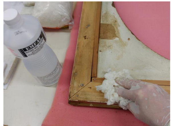
Fotografia 107- Desinfecção da moldura.
