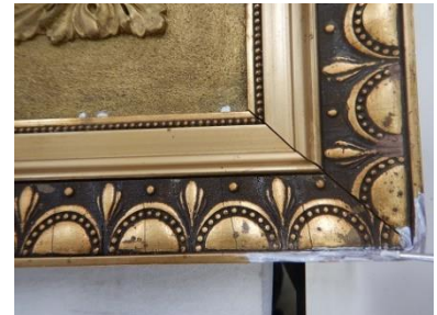
Fotografia 218- Massa de nivelamento sobre complementação de epóxi.
