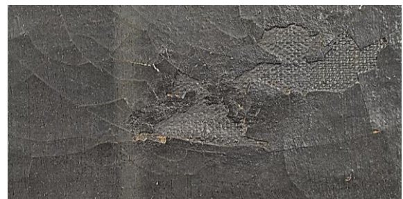
Fotografia 82- Detalhe de área com intervenção anterior.
