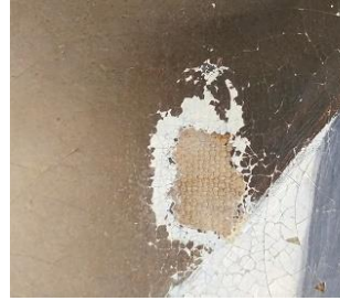
Fotografia 133- Após a remoção.
