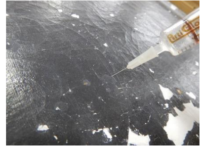
Fotografia 179- Aplicação do adesivo com seringa.
