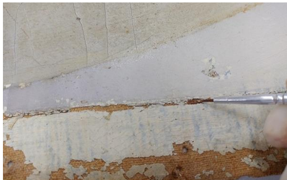
Fotografia 121- Aplicação do adesivo com pincel.
