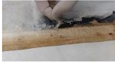
Fotografia 109- Remoção do faceamento no local do teste.
