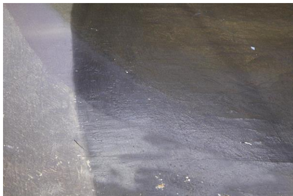
Fotografia 24- Concentração de verniz original.
