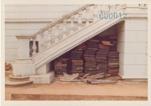
Figura 6 – Acervo sob uma das escadas externas de acesso ao edifício
