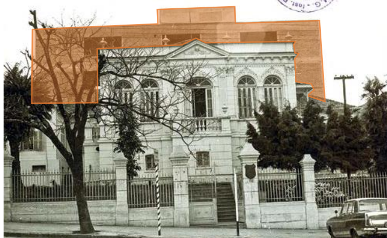
Figura 8 – Construção do edifício anexo do Arquivo Público Mineiro
