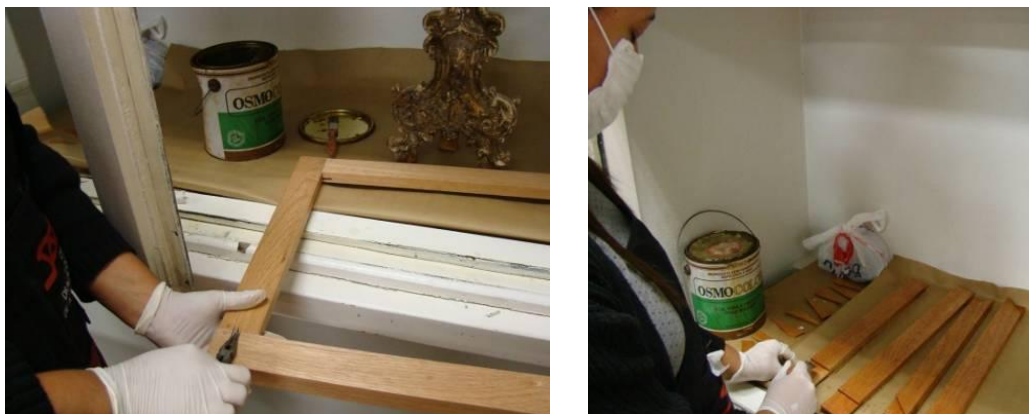
Figuras 36 e 37 – Detalhe da desmontagem e aplicação do Osmocolor no novo chassi Fotografia: Yukie Watanabe
