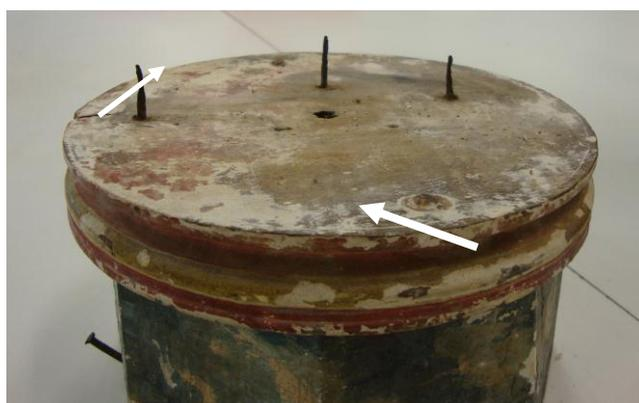
Figura 24 – Cravos de fixação dos blocos. As setas indicam a posição dos cravos maiores. Fonte: Otávio Borges
