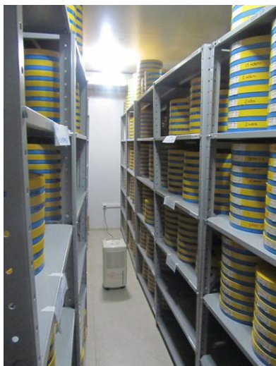
Figura 11 - Sala Fundo TV Globo Minas, no centro o desumidificador portátil. Autoria própria, 2012
