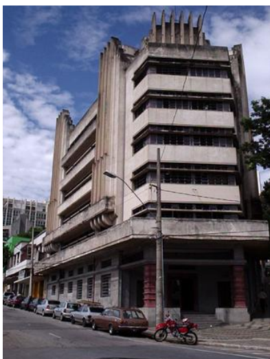
Figura 2 – Fachada Edifício Chagas Dória, 2005.
