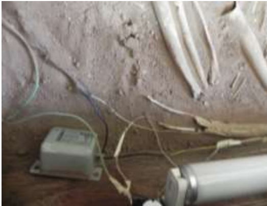
Figura 44 – Iluminação interna da vitrine
