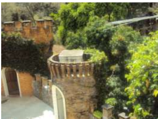
Figura 24 - Vista do Terceiro pavimento
