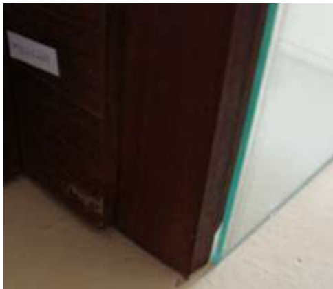
Figura 57 – Vedação inadequada
