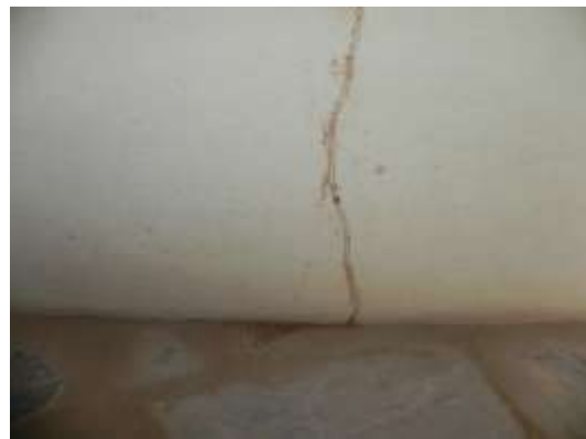
Figura 29 – Sinais de Cupins de solo
