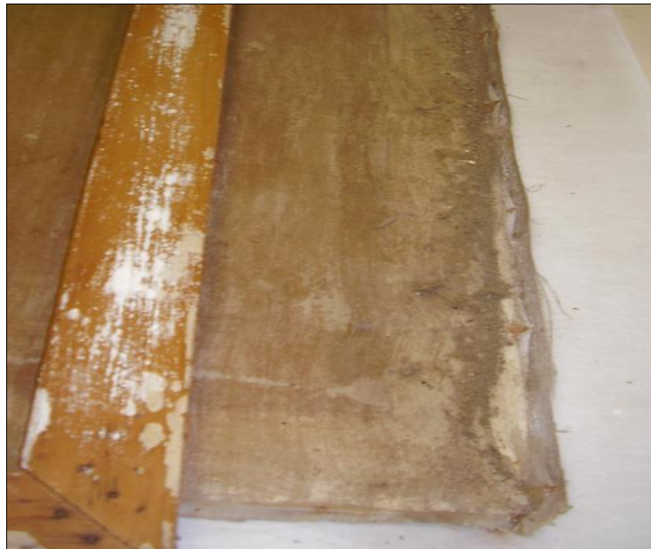
Figura 22 - Sujeira observada após remoção do chassis
