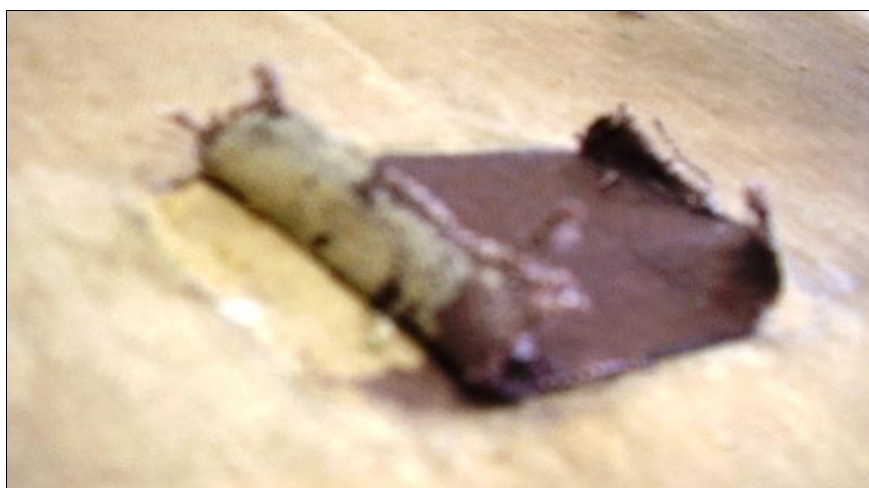
Figura 28 - Remoção dos remendos com uso de espátulas
