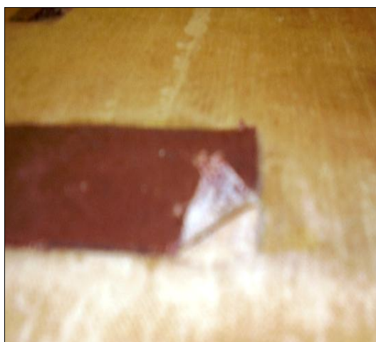
Figura 25- Remoção mecânica do remendo 1
