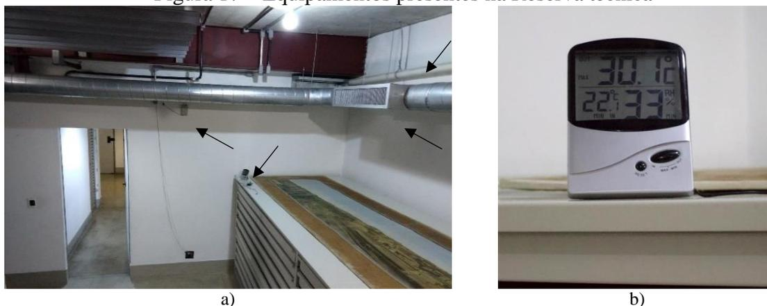
Legenda: a) Registro fotográfico da reserva técnica com indicação por setas do dispositivo CLIMUS (na parede), a tubulação do sistema de ar-condicionado e o termo-higrômetro sobre a mapoteca.
