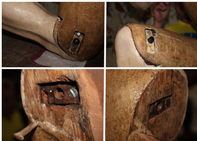
Fotografia 67 - Chapas de ferro onde são colocados os parafusos
