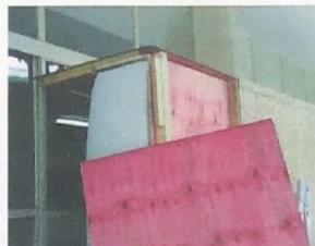
Detalhe do acabamento final da proteção física do painel
