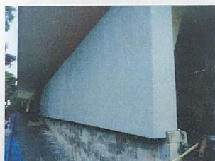
Acabamento final da proteção (Pintura)
