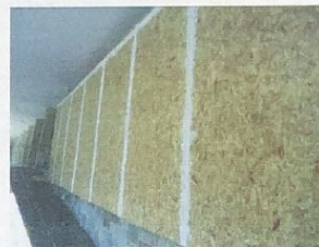
Término do acabamento final da proteção física do painel
