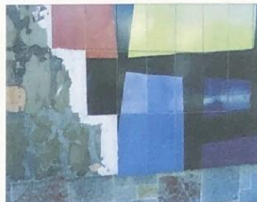
Detalhe da calafetação nas áreas de perda da cerâmica
