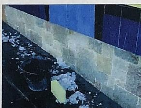
Remoção do Faceamento
