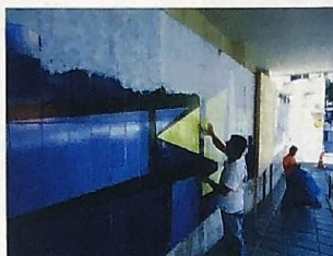
Remoção do Faceamento com água e esponja macia
