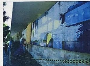
Remoção do Faceamento
