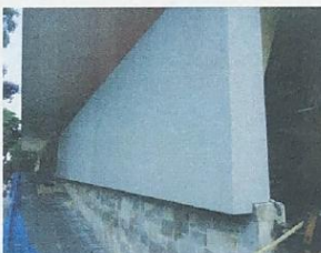
Acabamento final da proteção (Pintura)
