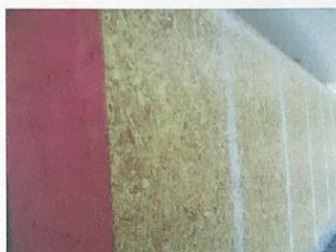
Término do acabamento final da proteção física do painel
