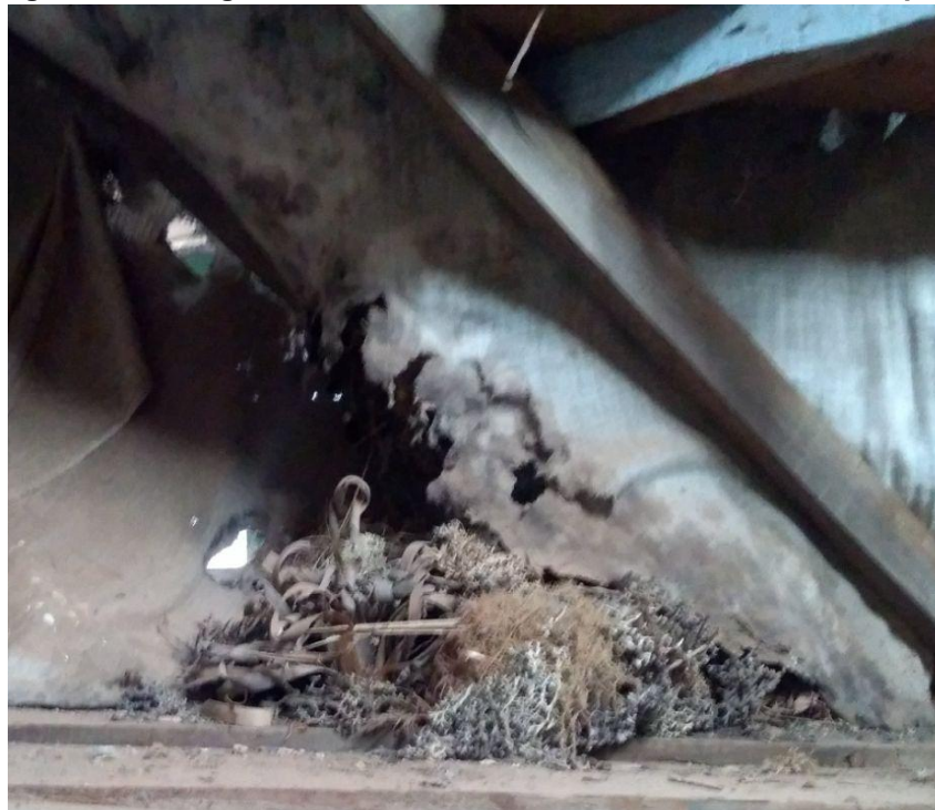
Figura 33 - Fotografia de Detalhe do verso da Estrutura do Presépio.
