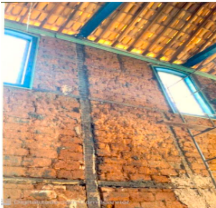
Figura 14 - Fotografia da técnica construtiva da parede da Igreja.
