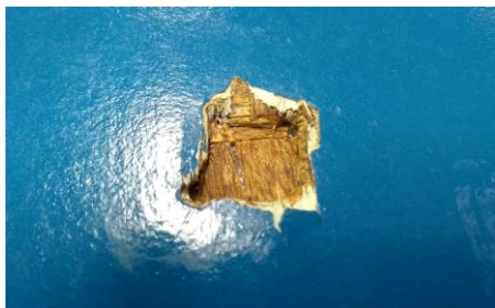
Figura 81: Vedação do buraco. Fonte: Fotos do autor, 2018.
