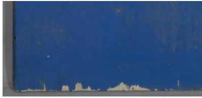
Figura 54: Desprendimento de tinta na parte inferior do verso da porta. Fonte: Fotos do autor, 2018.
