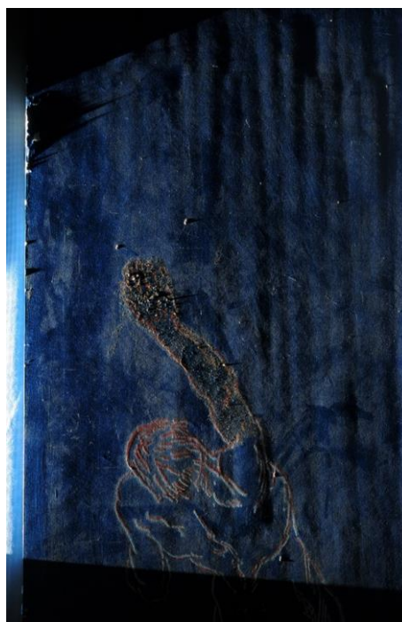
Figura 42: Frente da porta, iluminada com luz rasante. Detalhe da parte superior. Fonte: Fotos de Cláudio Nadalin, 2018.
