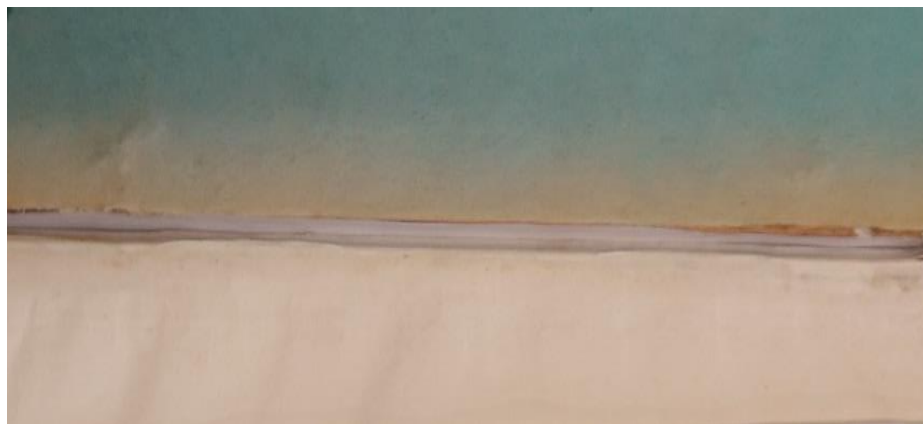
FIGURA 29 – Fotografia sob luz direta, em detalhe, da charneira rompida
