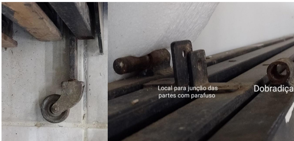
Figura 5 - A esquerda, detalhe do rodízio do painel de abertura. À direita, detalhe da composição de dobradiças dos painéis.
