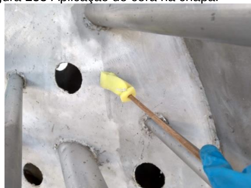
Figura 233 Aplicação de cera na chapa.
