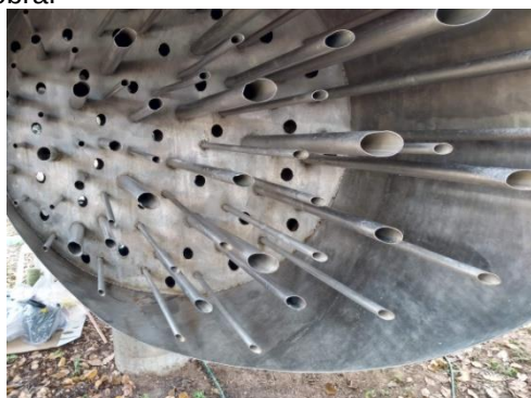
Figura 245 Após limpeza úmida na parte inferior da obra.
