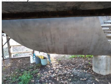
Figura 172 Limpeza parte inferior do cilindro (lateral direita da obra).
