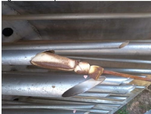
Figura 142 Limpeza do tubo.
