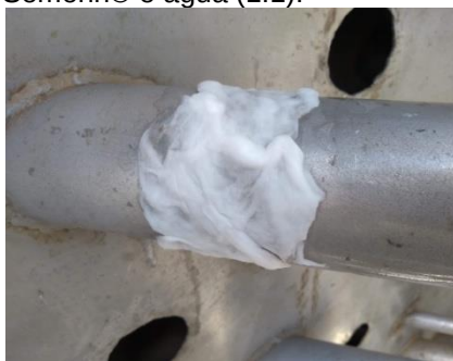
Figura 203 Compressa de Semorin® e água (1:1).
