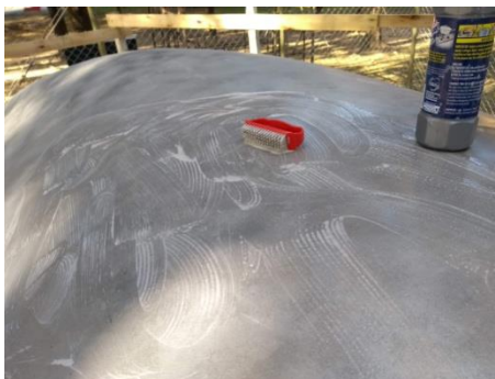
Figura 167 Limpeza do cilindro.
