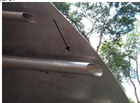
Figura 51 Marca interna de emenda na chapa do cilindro.
