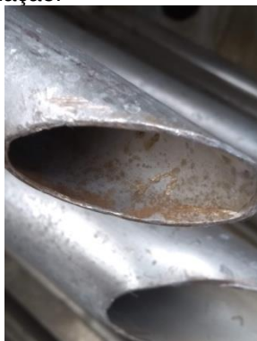
Figura 193 Oxidação antes de compressa com EDTA a 5% com hidróxido de sódio sobre oxidação.
