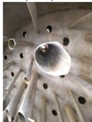
Figura 145 Tubo após limpeza.
