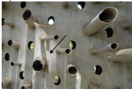
Figura 53 Emenda chapa (parte anterior da obra).
