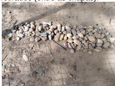
Figura 138 Montante de detritos retirados (entre as chapas).
