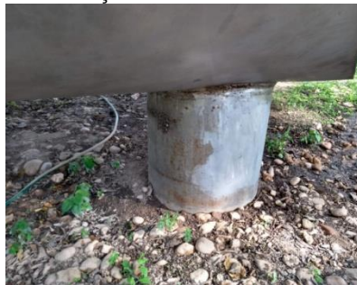
Figura 265 Tratamento de desoxidação em andamento.
