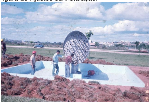
Figura 15 Ajustes da instalação.
