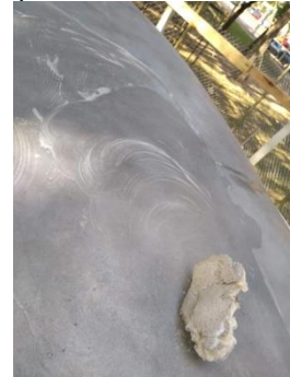
Figura 168 Limpeza com estopa.
