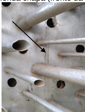
Figura 52 Emenda chapa (frente da obra).
