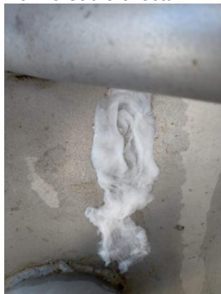
Figura 209 Compressa de Semorin® sobre o local.
