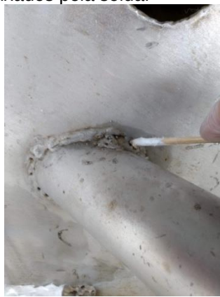
Figura 212 Swab em orifícios deixados pela solda.
