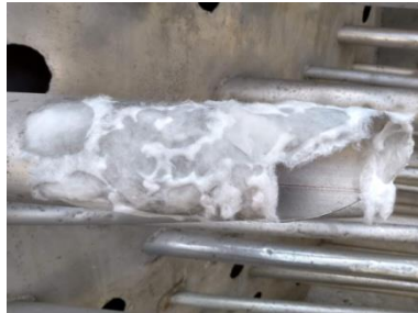
Figura 224 Compressa com Semorin®.
