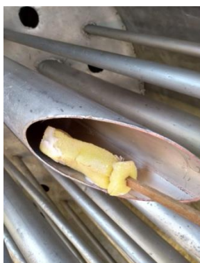
Figura 232 Aplicação de cera no interior dos tubos.
