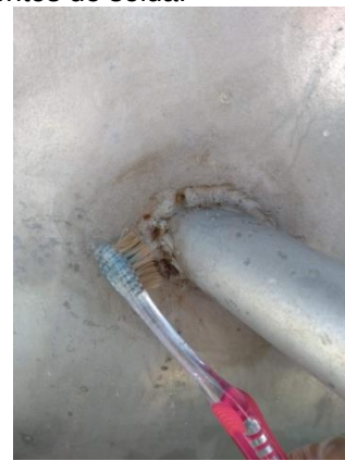
Figura 213 Escova sobre pontos de solda.
