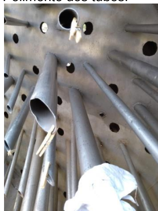
Figura 239 Polimento dos tubos.
