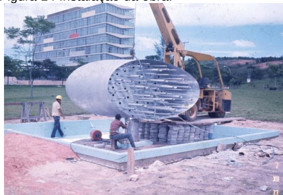
Figura 14 Instalação da obra.
