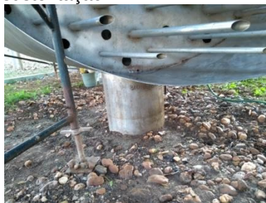
Figura 173 Limpeza cilindro de sustentação.
