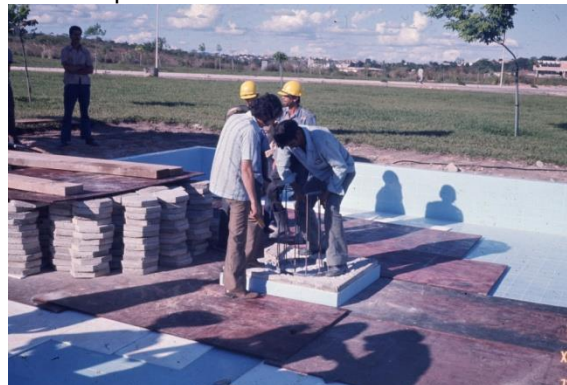
Figura 10 Construção da estrutura de ferro e alvenaria para sustentar a obra.
