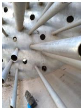
Figura 128 Antes da limpeza mecânica.
