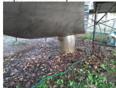
Figura 174 Limpeza parte inferior do cilindro (lateral esquerda da obra).
