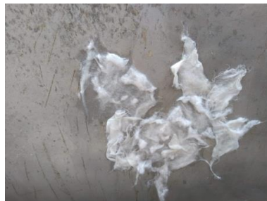
Figura 206 Compressas sobre as ranhuras.
