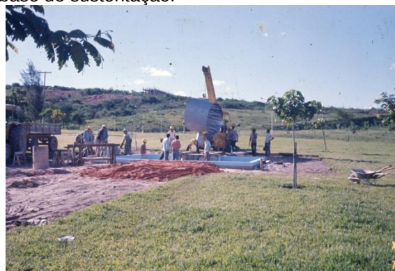
Figura 12 Fixação da parte superior da obra na base de sustentação.
