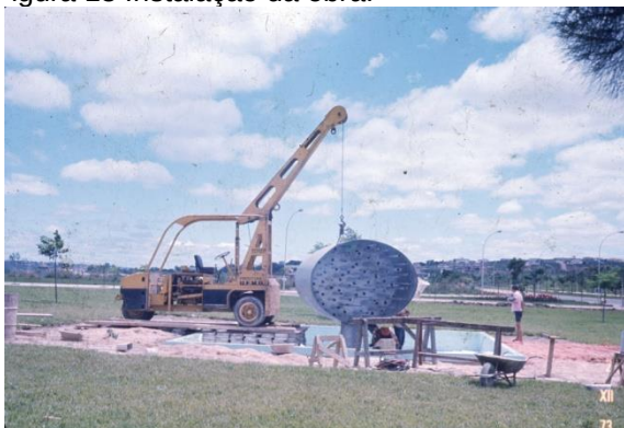
Figura 13 Instalação da obra.
