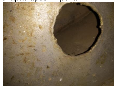
Figura 140 Espaço entre as chapas após limpeza.
