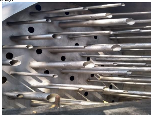
Figura 243 Após polimento (parte anterior da obra).
