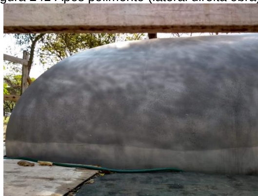
Figura 241 Após polimento (lateral direita obra).
