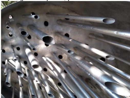
Figura 221 Após trabalhos de remoção das oxidações (frente da obra).
