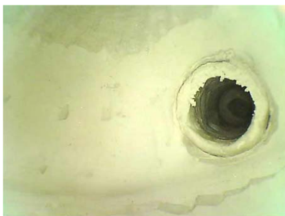
FIGURA 8 – Vista interna demonstrando a técnica construtiva (detalhe da união da cabeça da ave direita). Foto realizada com o equipamento Intracam. Foto: Agésilau Neiva Almada, 2013.
