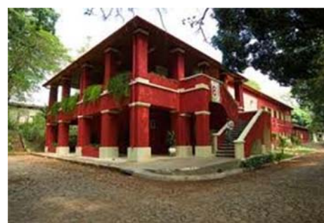
FIGURA 18 – MHNJB/UFMG, Vista da edificação central. Foto: disponível em http://www.mhnjb.ufmg.br/administracao.html , consultado em 26/05/2013.
