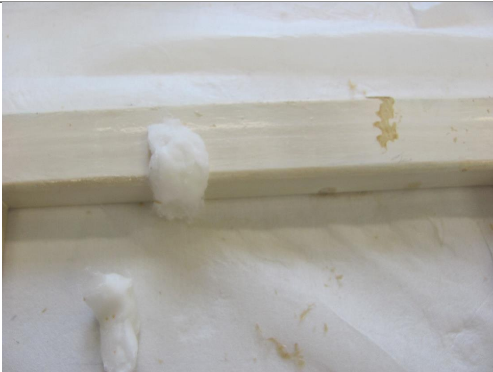
FIGURA 08: Compressa de água nos locais com aderência de fita adesiva
