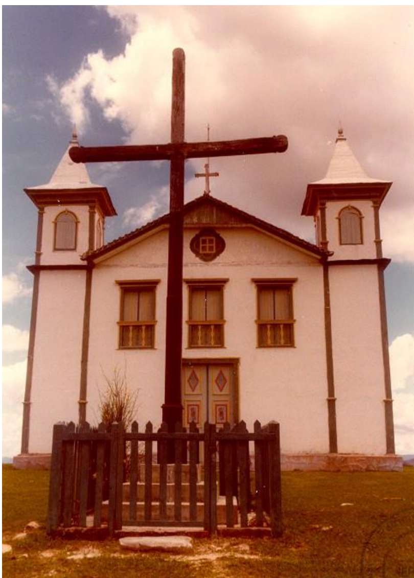
Figura 2 – Fachada frontal da Igreja Matriz de São Gonçalo (Foto: Arquivo/IEPHA - 1980)
