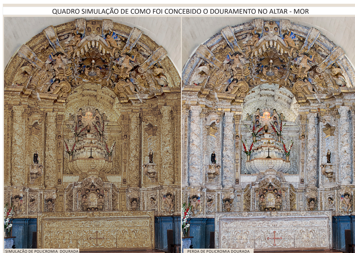
FIGURA 01 - Retábulo do Altar - Mor - Quadro simulando aspecto da policromia dourada que recobriu totalmente a talha no momento de sua concepção. Atualmente grande parte da superfície se encontra somente na base de preparação branca. Foto: André Andrade, 2016.
