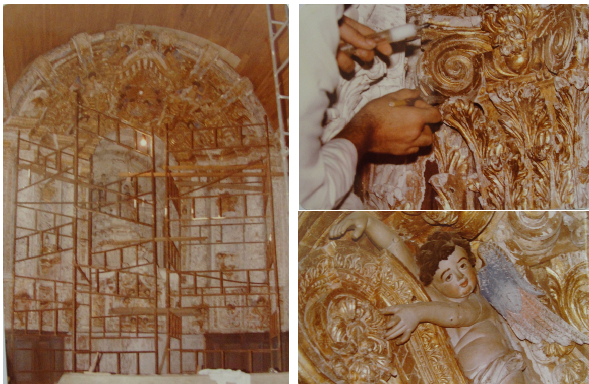
FIGURA 13 - Retábulo do Altar - Mor - Imagem da intervenção de 1984, que procedeu limpeza e fixação da policromia . Fica evidente os mesmo danos que observamos atualmente. Detalhe mostrando fixação do douramento via injeção de adesivo. Reprodução arquivo IEPHA, 2016.
