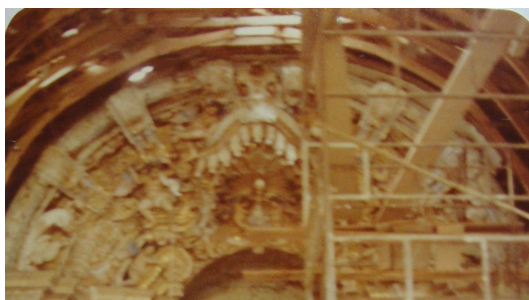
OBRA DE 1984 - REMOÇÃO TOTAL DO FORRO PRIMITIVO
