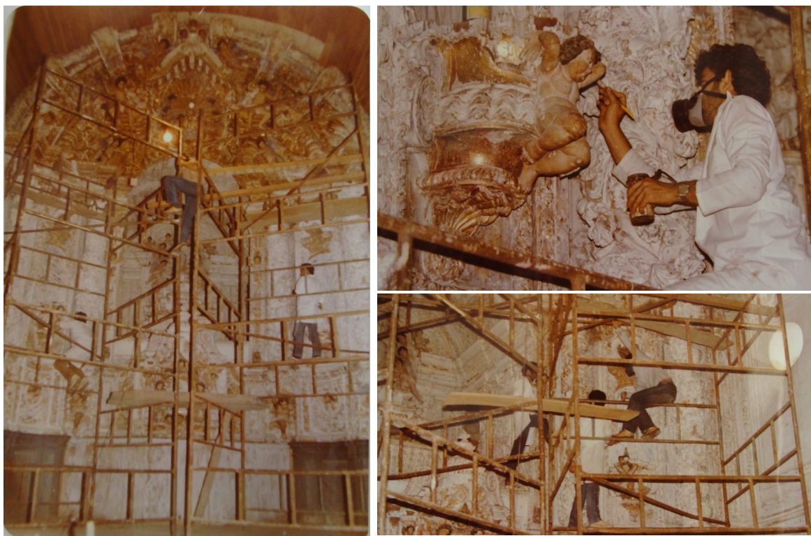
FIGURA 14 - Retábulo do Altar - Mor - Imagem da intervenção de 1984, que procedeu limpeza e fixação da policromia . Fica evidente os mesmo danos que observamos atualmente. Detalhe de momento de fixação do douramento via pincelamento. Reprodução arquivo IEPHA, 2016.
