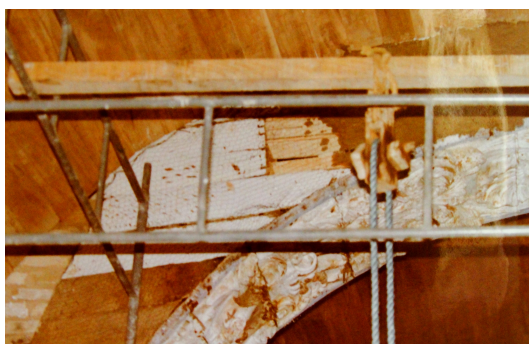
OBRA DE 1984 - APROVEITAMENTO DE TÁBUAS DO FORRO PRIMITIVO NO ARCO CRUZEIRO
