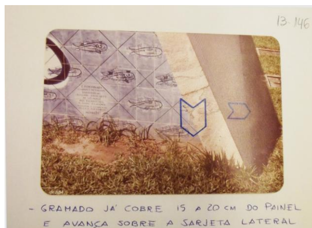
FIGURA 14: Aterramento das duas primeiras fileiras de azulejo
