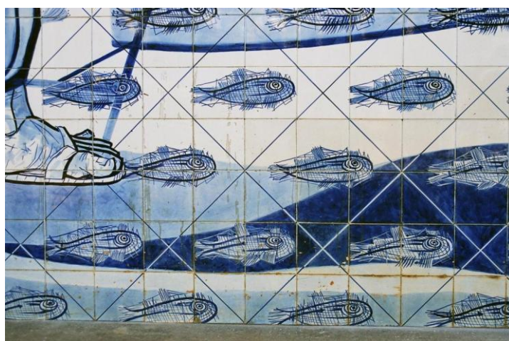
FIGURA 15: Manchas de resina escorrida Fonte: Relatório final da construtora Biapó, 2005
