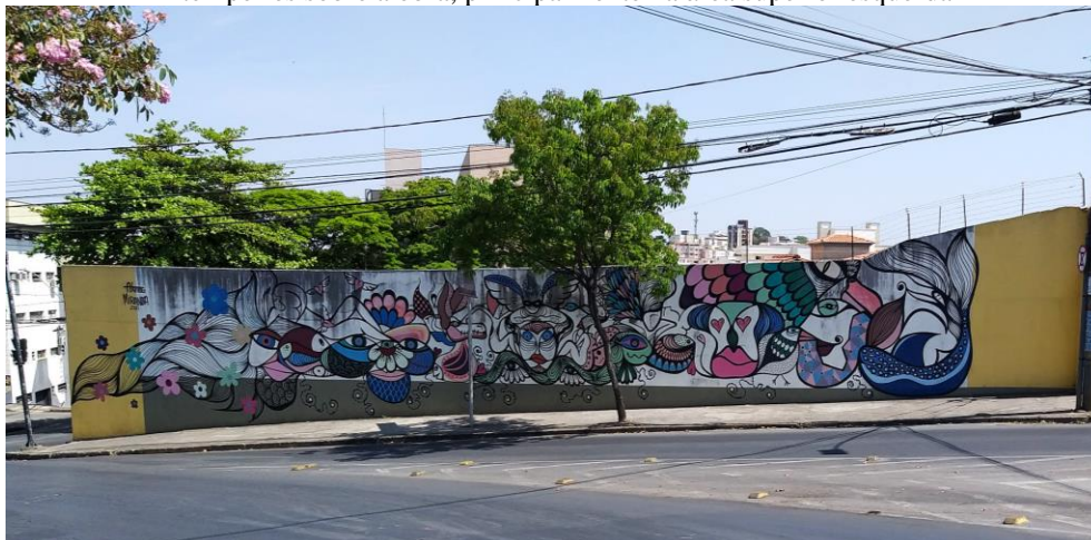
Figura 29 – Obra de Ataíde Miranda no Bairro Ouro Preto (BH) onde é possível perceber a ação das intempéries sobre a obra, principalmente na área superior esquerda
